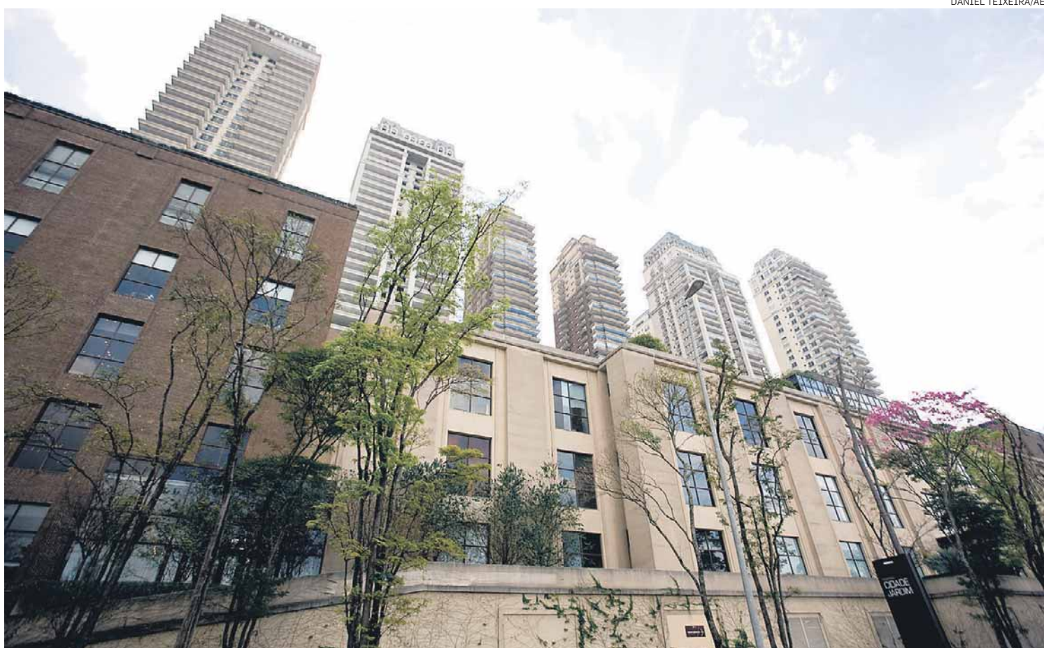
Cidade Jardim. Complexo de luxo terá torres comerciais com sistemas de reúso de água e de economia de eletricidade
