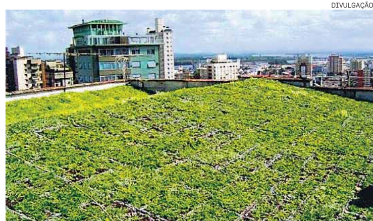
Telhado. Cobertura verde em prédio reduz o calor interno
